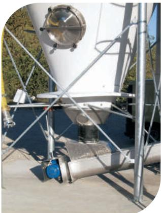
Sistema Milksilo AGRITECH in acciaio inox con raccordo tra fondo vibrante e coelie di estrazione a canalina con motoriduttore ed apposito carter di protezione
